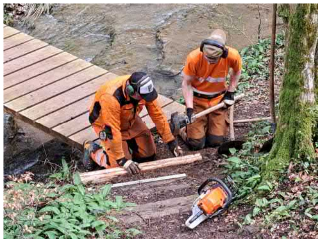
Ersatz von Treppenstufen, Foto: Samuel Bürgin
