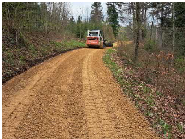
Belagsarbeiten im Stolten, Foto: Samuel Bürgin
